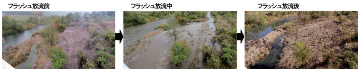
フラッシュ放流時の旧河道への導水状況
