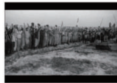
地域住民・土木技術者一丸 となった復旧作業
