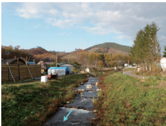
元町川施工（控え護岸区間）
