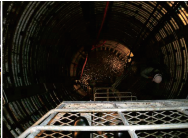
集水井での排水状況確認
