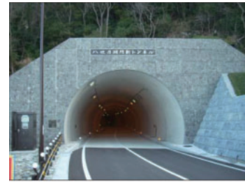
完成（坑口面壁）
