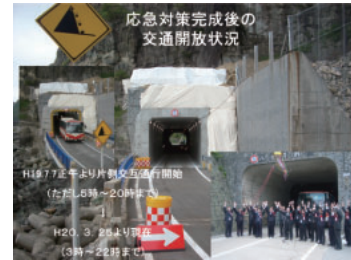
応急対策完成
