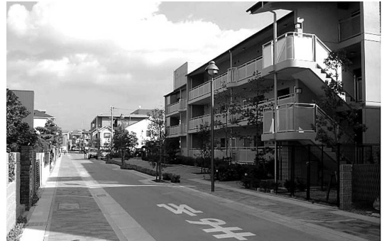
コミュニティ道路・電線類地中化
