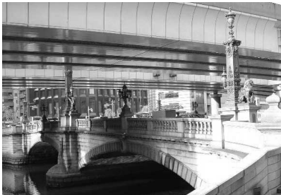
首都高速道路が上空を覆う現在の日本橋
