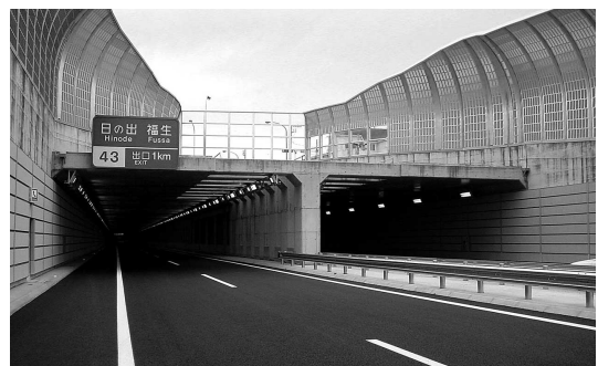
掘割構造区間
