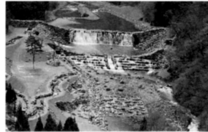
しのぶ砂防ダム親水整備事業全景
