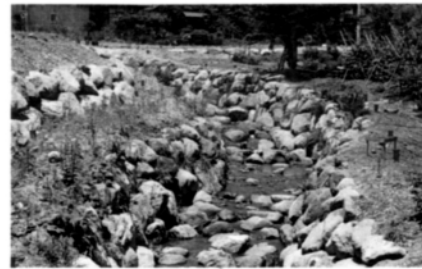
発生材による石積と河床調整
