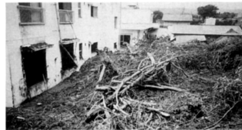
土砂崩壊状況
