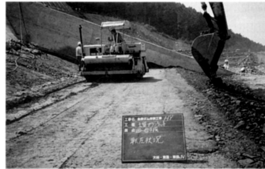
土質ブランケット施工状況
