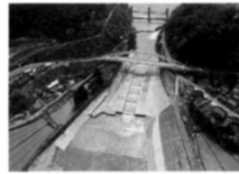
完成した愛本床止工
