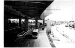
橋脚横梁と主桁の一体構造
