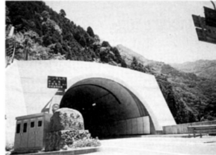
寒風山トンネル坑口（愛媛県側）
