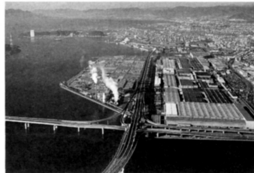
高速3号線（仁保 JCT～宇品ランプ）全景
