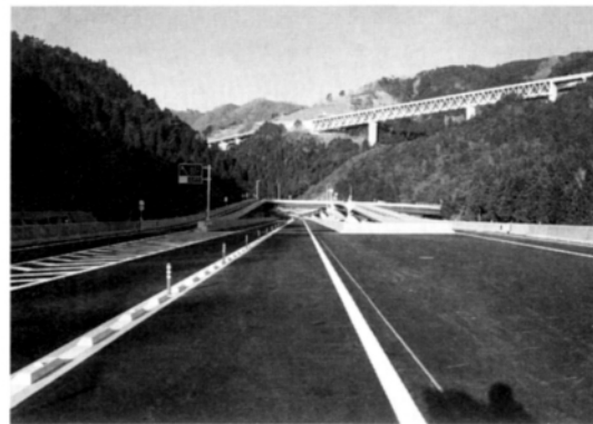
向子駄良高架橋から油坂第七橋を望む
