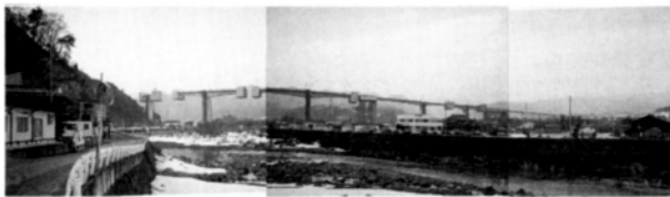
大型ワーゲンによるPCラーメン橋施工
