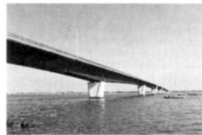
下流側からスマートな曲線の本橋を望む
