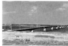
右岸 (千葉県側) 下流側から本橋を望む
