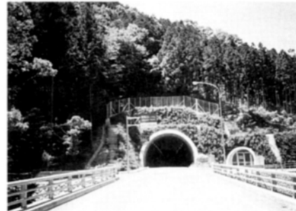
寒風山トンネル坑口（高知県側）
