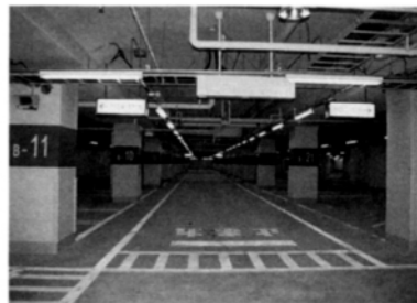
帯広駅北地下駐車場内
