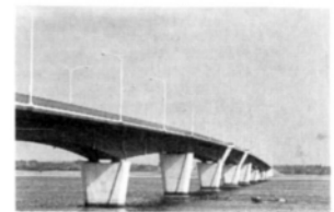
下流側から本橋を望む (中央2カ所がバルコニー)
