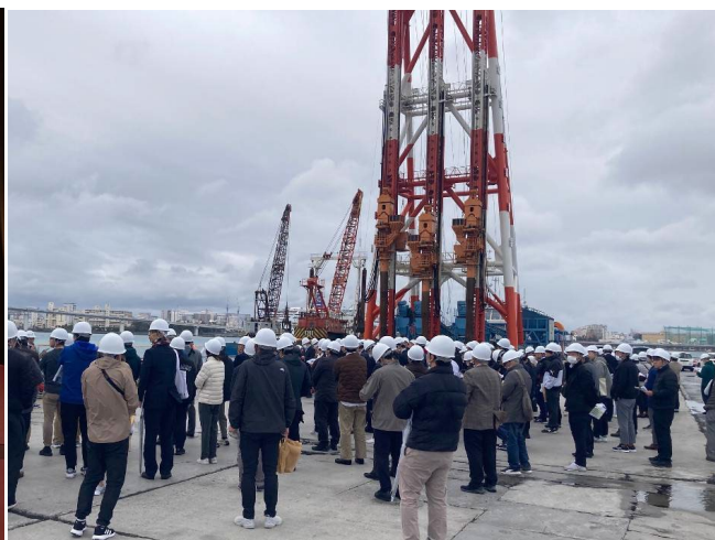
現場研修の様子 「那覇港新港ふ頭地区岸壁地盤改良工事」
