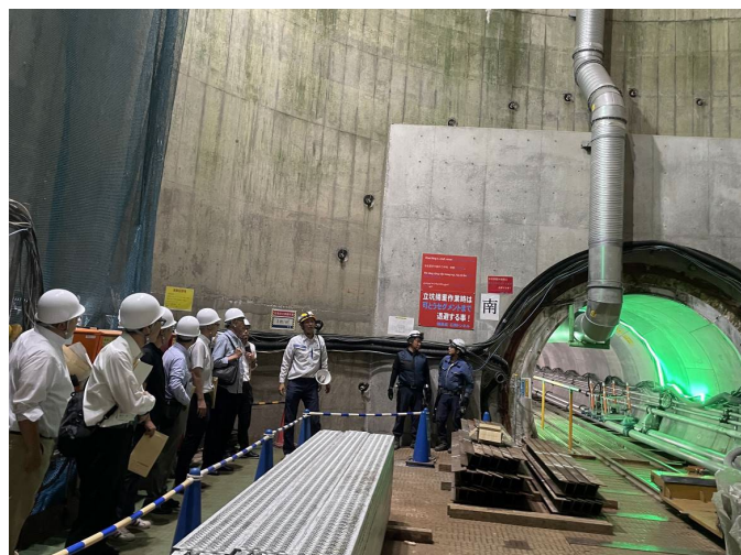
現場研修の様子「霞ヶ浦導水事業（堅倉立坑）」
