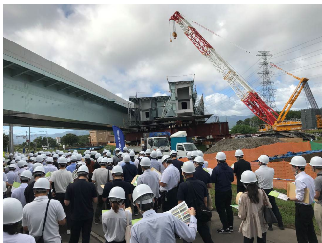
現場研修の様子「屯田・茨戸通整備事業」 (大型クレーンによる鋼桁架設工事現場)
