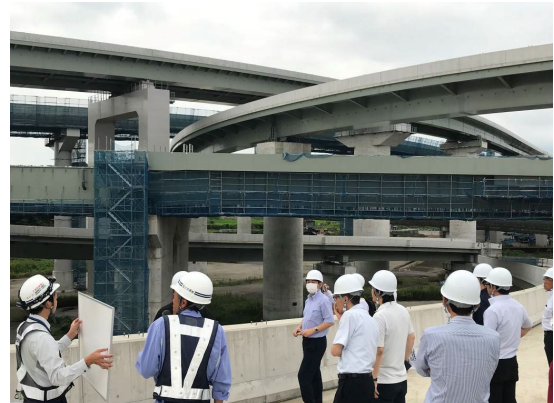
【高速横浜環状南線（栄工区）での視察の様子】
