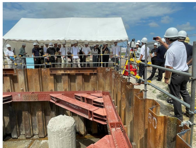
現場研修の様子「一般国道8号六家立体事業」 (ICT技術を用いた基礎杭出来形管理 他)
