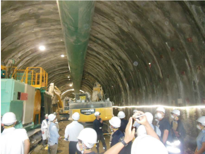
【呉トンネル工事現場での視察の様子】
