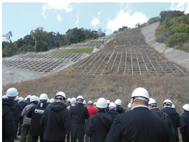
現場研修の様子 「災害関連緊急急傾斜地崩壊対策事業（古里工区）」
