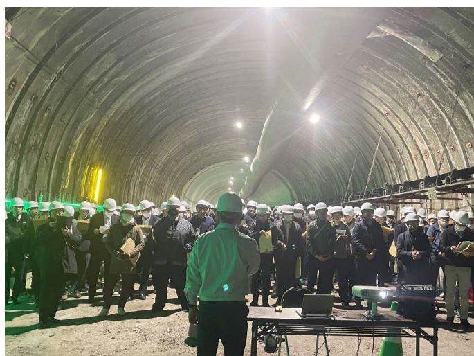
現場研修の様子 「中津日田道路 日田山国道路5号トンネル」
