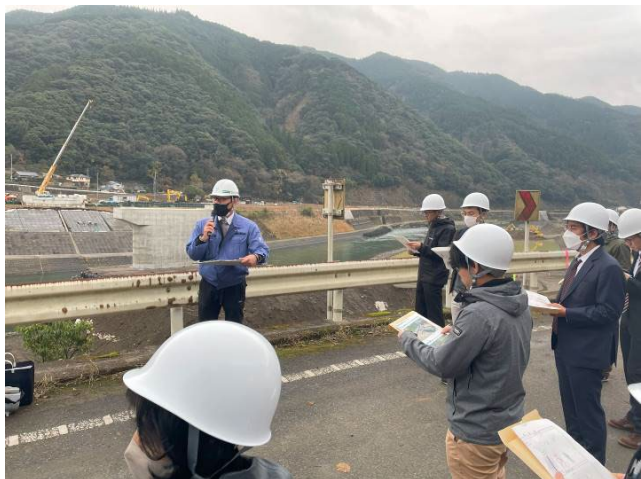
【坂本橋橋梁復旧現場での視察の様子】
