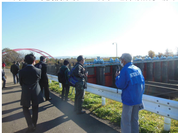
【大河津分水路旧洗堰の視察の様子】
