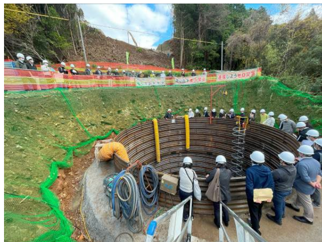
【熊本3号境川橋下部工(P1)工事現場での 視察の様子】
