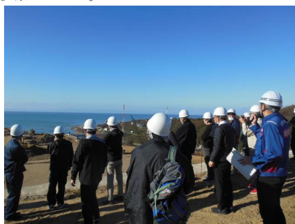
【左岸山地部掘削現場での視察の様子】
