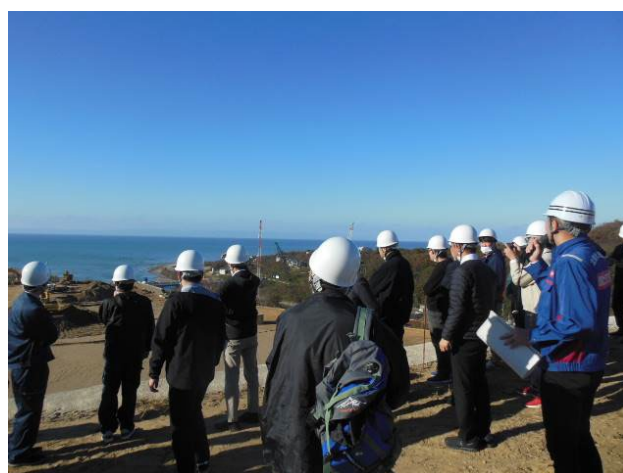
【左岸山地部掘削現場での視察の様子】
