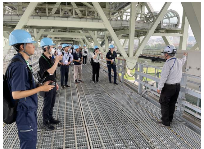
【中央管理用通路での視察の様子】
