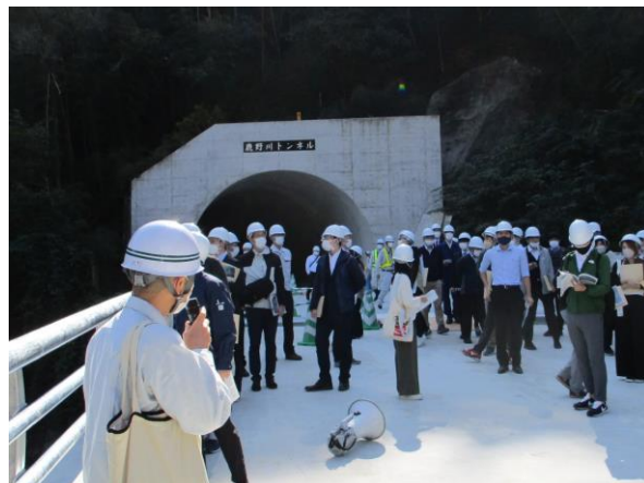
現場研修の様子「主要地方道小田河辺大洲線 鹿野川バイパス整備事業」
