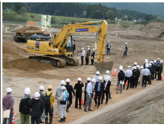
現場研修の様子 (ICT 建機の状態等) 「阿武隈川緊急治水対策プロジェクト」
