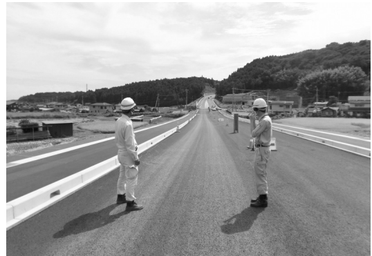
日立いわき線区間（供用開始前）を眺める様子
