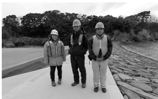
防潮堤復旧工事の完成時の様子（平成29年度撮影）
