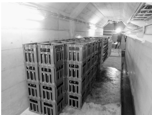
余地ダムにおける貯蔵状況
