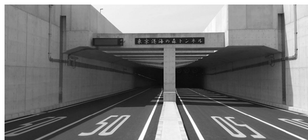
中央防波堤側トンネル出入口
