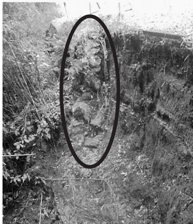
写真-1 現地状況（土のうによる土留）
