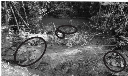
写真-2 現地状況（土のう散乱）
