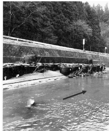
写真-3 現地状況（大型土のう）
