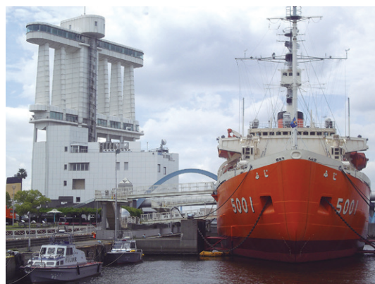
写真-2 名古屋港ポートビル（左）と南極観測船“ふじ”
