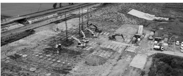
深層混合処理工法による基盤改良
