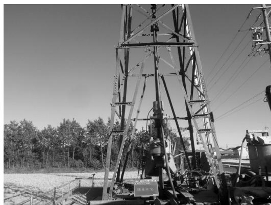
井戸掘削状況写真
