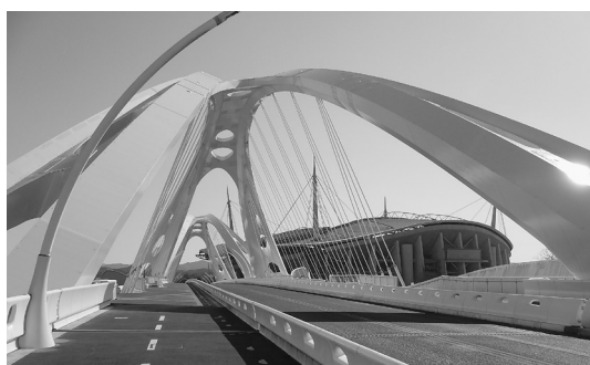
豊田大橋（ニールセンローゼ橋）と豊田スタジアム
