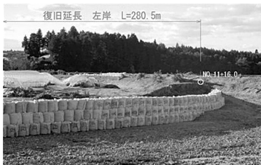
写真-1 仮締切の実施例
