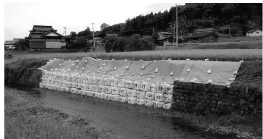
写真-2 欠壊防止の実施例
