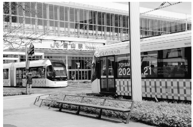
南北直通運行する路面電車（富山駅）
