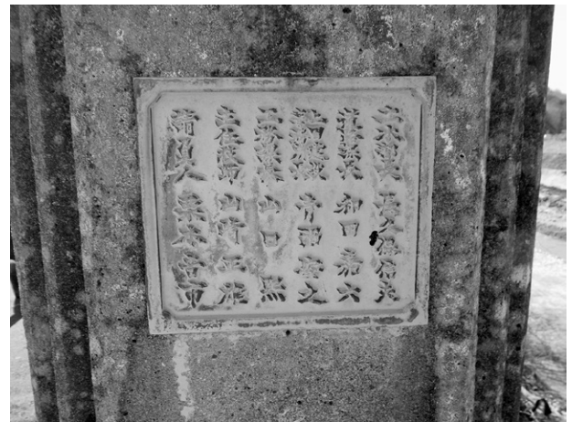
写真-2 親柱に残された技術者の銘板
