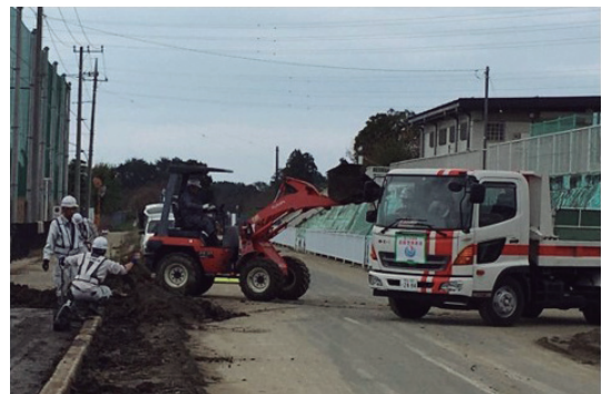
写真－8 道路清掃支援チームの活動状況（埼玉県東松山市）
