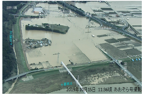
写真－6 河川氾濫浸水状況 常磐自動車道水戸北SIC付近
