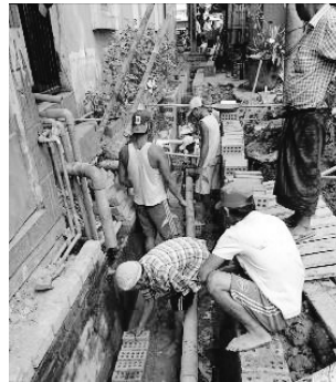
水路築造の様子
