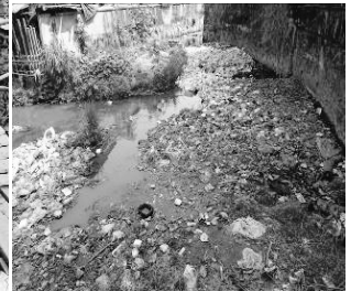
水路のごみ堆積
