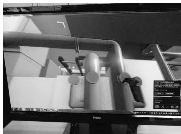
写真-4 VRにて計器類位置確認状況
