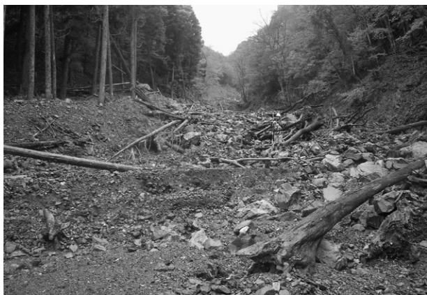
写真-2 苦労した熊本県：川辺川水系の砂防調査
