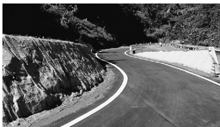
写真-2 仮道施工後
