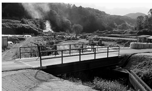
写真-3 仮橋設置後
