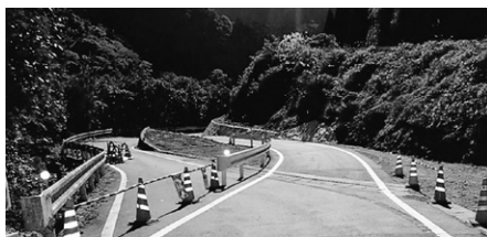
写真-1 仮道施工後
