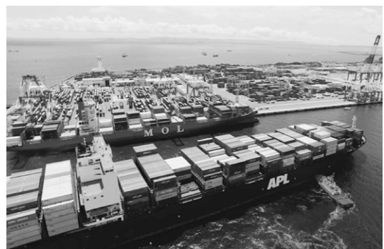
写真-2 国際コンテナ戦略港湾の例(阪神港)
