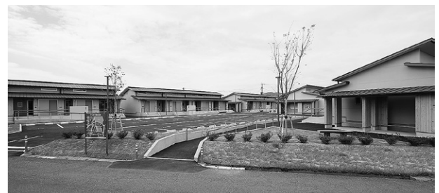
写真-2 災害公営住宅
