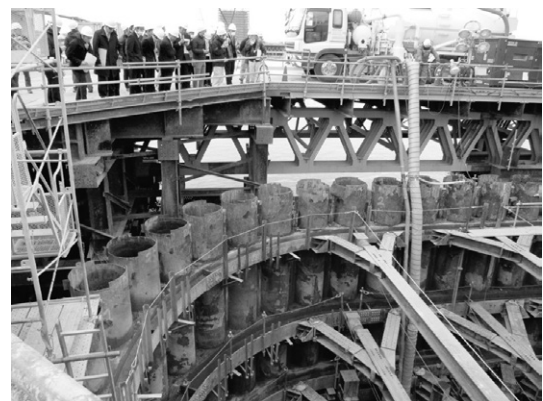
現場研修の様子 「四国横断自動車道建設事業（新直轄）」
