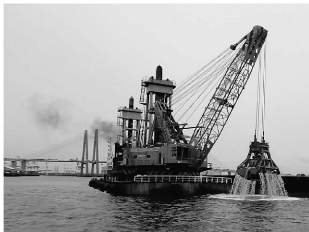
写真-1 グラブ浚渫船による浚渫状況
