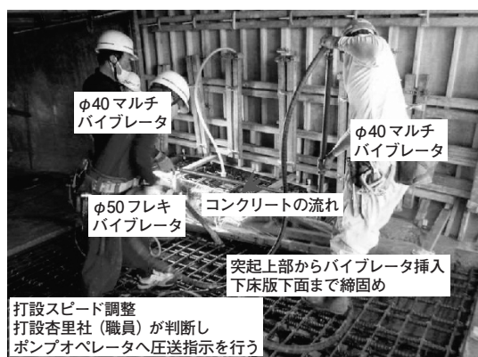
写真－4 打設状況
