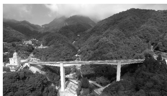
写真－6 湯の山かもしか大橋（開通後）
