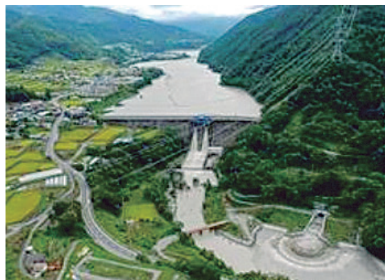
写真-1 天竜川水系美和ダム 土砂バイパストンネル
