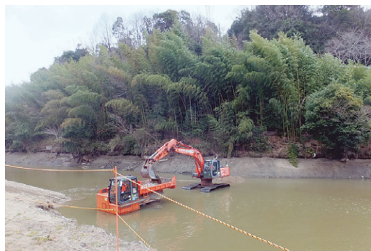
写真－3 水陸両用のバックホウ及びクローラダンプ
