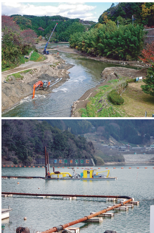
写真－2 クラムシェル・バックホウ（上側） ポンプ船（下側）による堆砂除去
