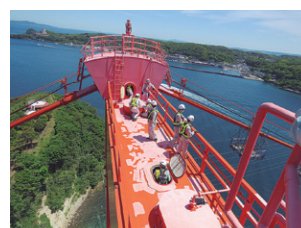
平戸大橋主塔の点検
