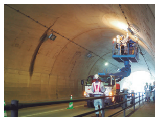
トンネルの点検
