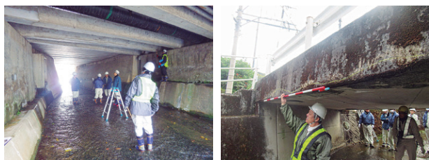
写真－3 長崎市の小規模橋梁の道守と市職員の共同点検
