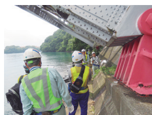
西海橋アーチ基部の点検
