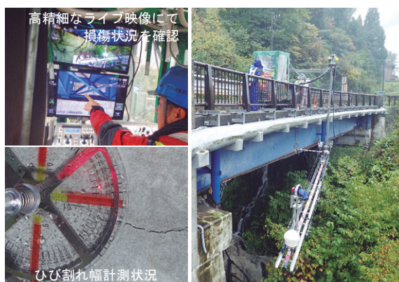
写真-3 橋梁点検支援ロボットによる点検状況
