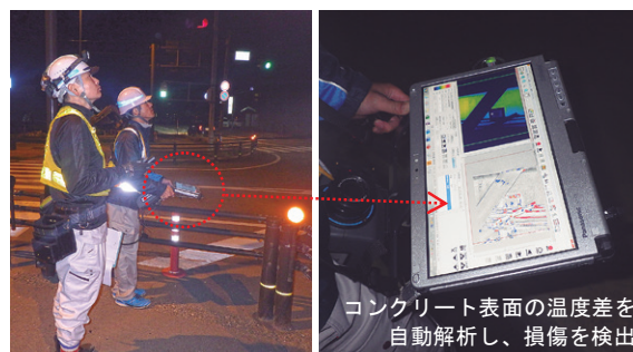
写真-4 赤外線トータルサポートシステムによる点検状況
