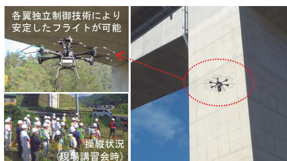
写真-2 可変ピッチ機構付ドローンによる点検状況
