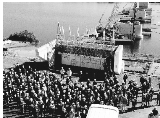
現場研修の様子 「一般県道羽鳥稲沢線（新濃尾大橋）建設事業」
