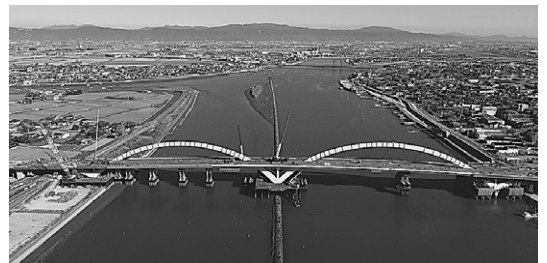
写真-1 筑後川橋（仮称）の施工状況
