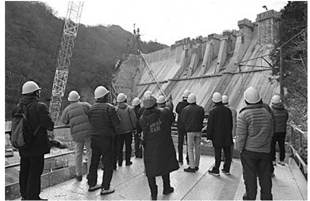
写真-4 ハッ場ダム
