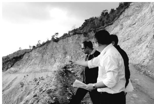
写真－1 斜面崩壊箇所の現地調査の様子
