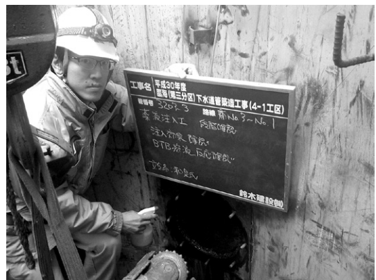
下水道管築造現場 立坑内にて
